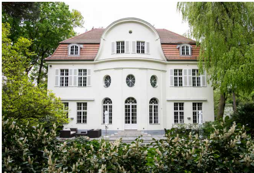
Blick auf die Villa in der Pücklerstraße in heutiger Zeit
