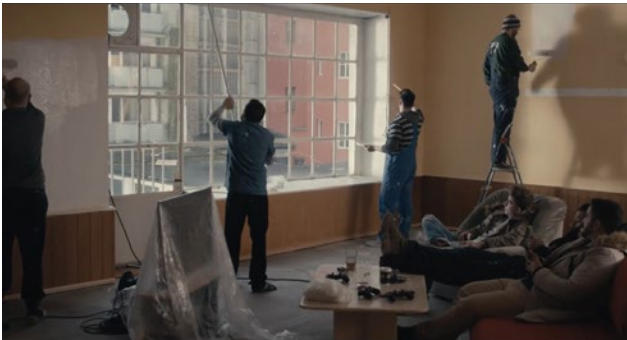
Renovierung des Gemeinschaftsraums
