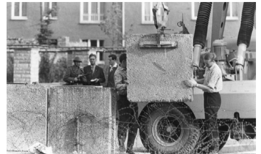
— Abb.: Bauarbeiter stellen unter Aufsicht Betonblöcke auf
